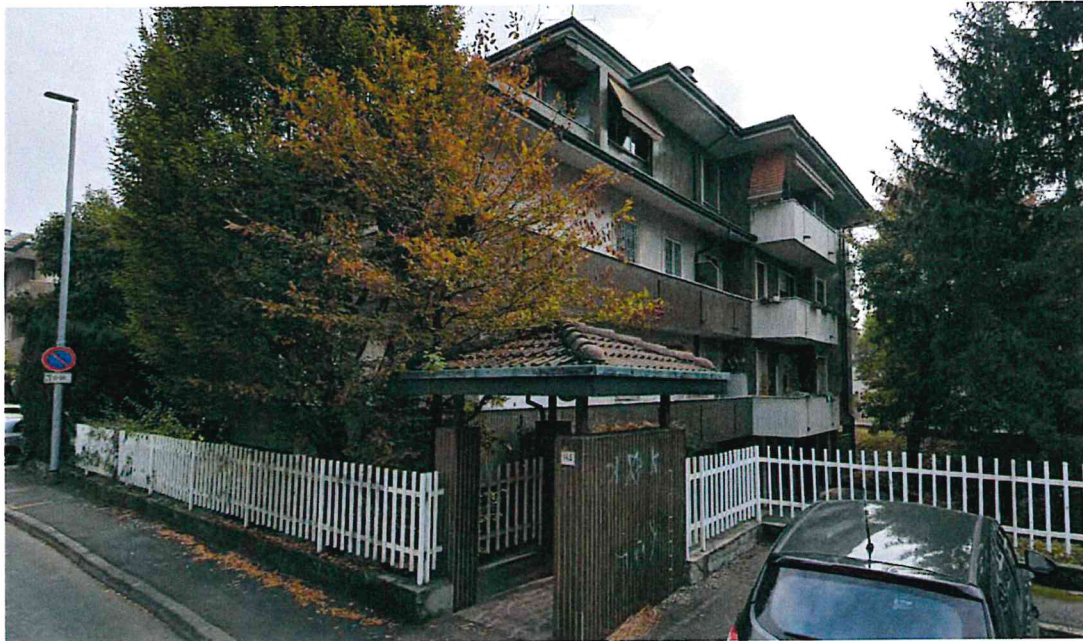
Foto n. 1: Vista condominio civico 145 da via San Carlo Borromeo
