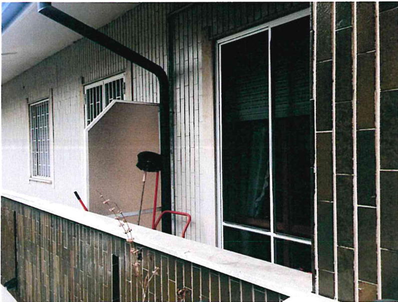
Foto n.14: Corpo A – vista balcone cucina
