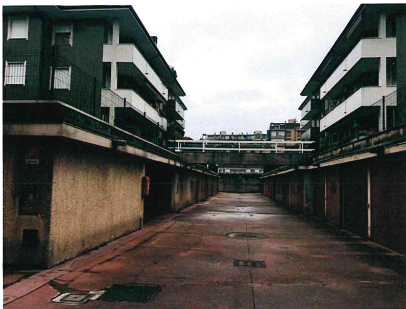
Foto n.24: Corpo B – vista corsello comune e individuazione accesso Box
