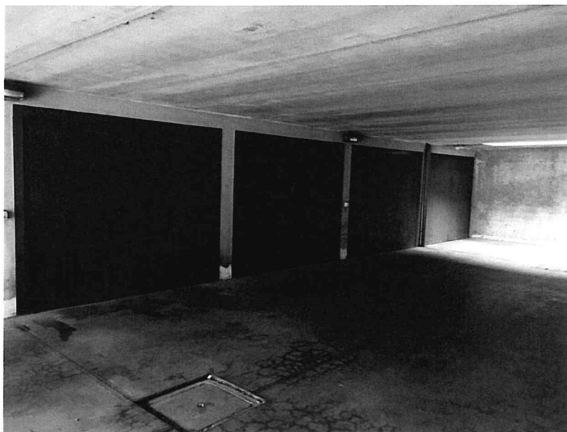
Foto n.25: Corpo B – individuazione Box di pertinenza
