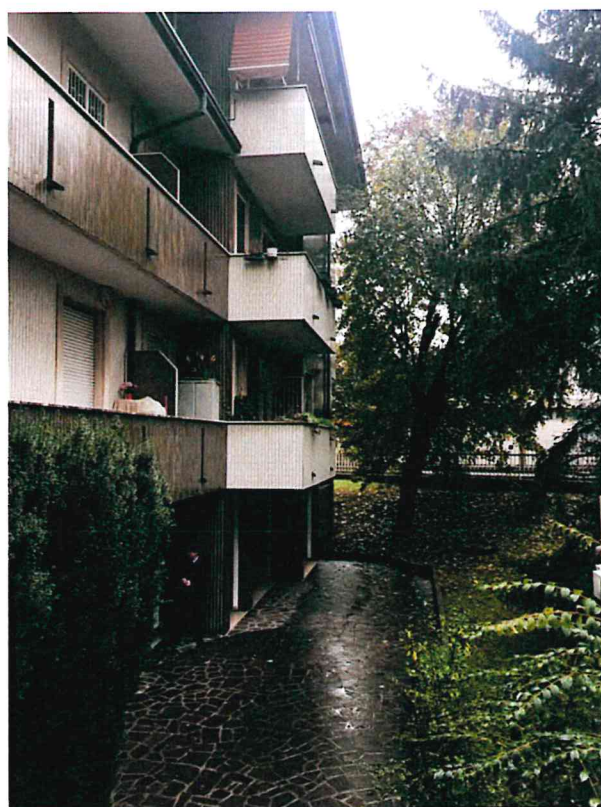
Foto n. 4: Vista esterna ingresso condominio e appartamento
